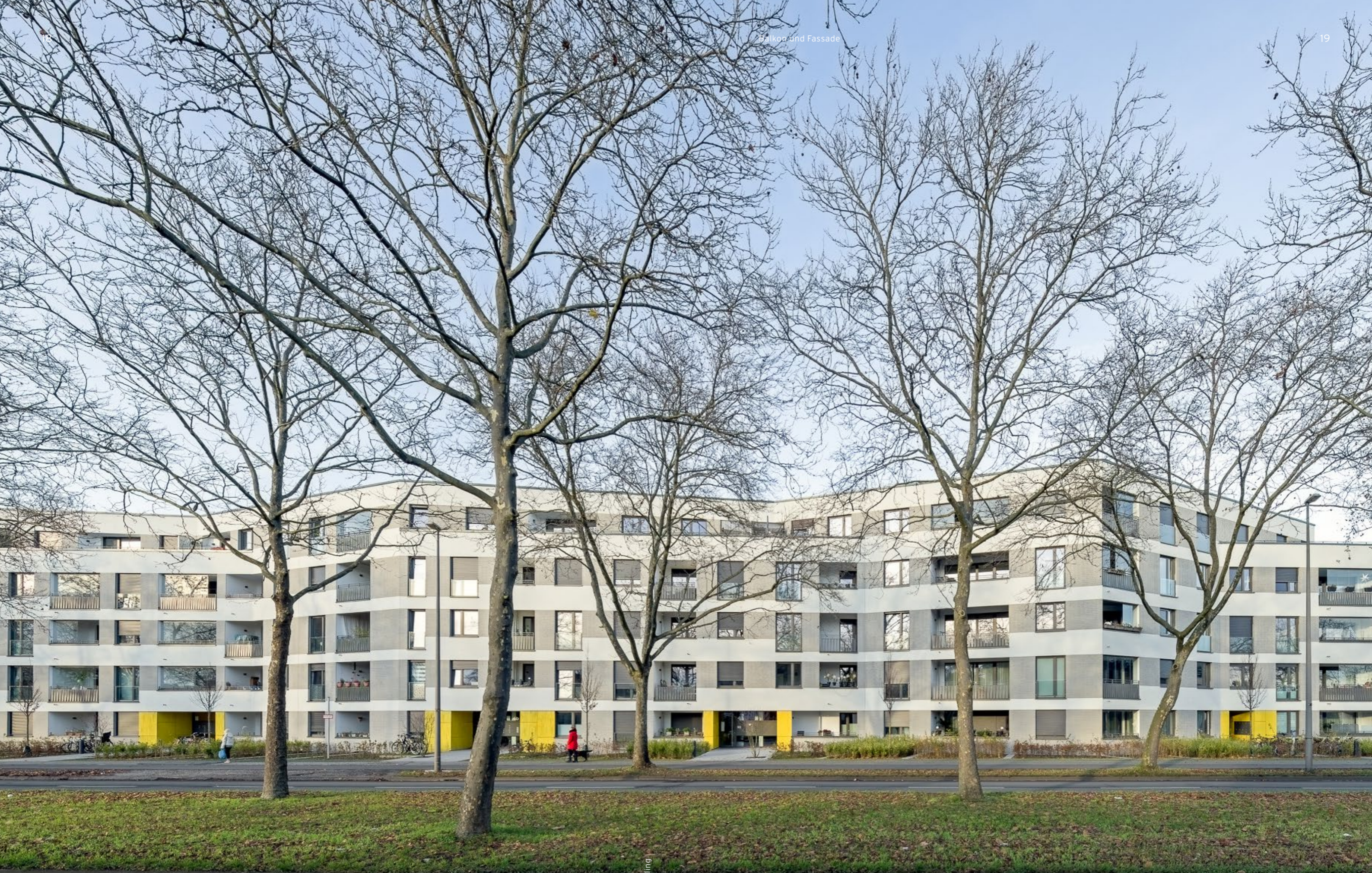
Ref. 1899 Wohngebäude Vorgebirggärten in Köln
